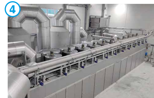
Firma Emter in Altenstadt + Kläranlage Penzing
