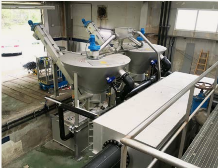
Dosierte Zugabe via Sandpumpe in die HUBER Coanda Sandwaschanlagen RoSF4: HUBER Sandfang GritWolf® in Loiola (Spanien).
