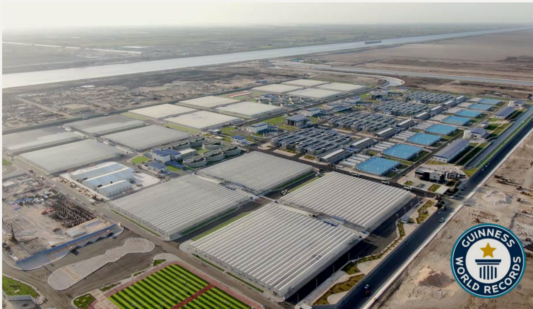
650.000 m 2 Fläche: Die Wasseraufbereitungsanlage Bahr El-Baqar wurde von Guinness World Records mit mehreren offiziellen Weltrekorden ausgezeichnet (© Orascom Construction und The Arab Contractors).
