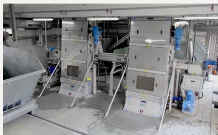
Der HUBER Harken-Umlaufrechen RakeMax® HF mit der gekröpften Rahmenkonstruktion ist von außen fast nicht von der bewährten Basismaschine RakeMax® zu unterscheiden.
