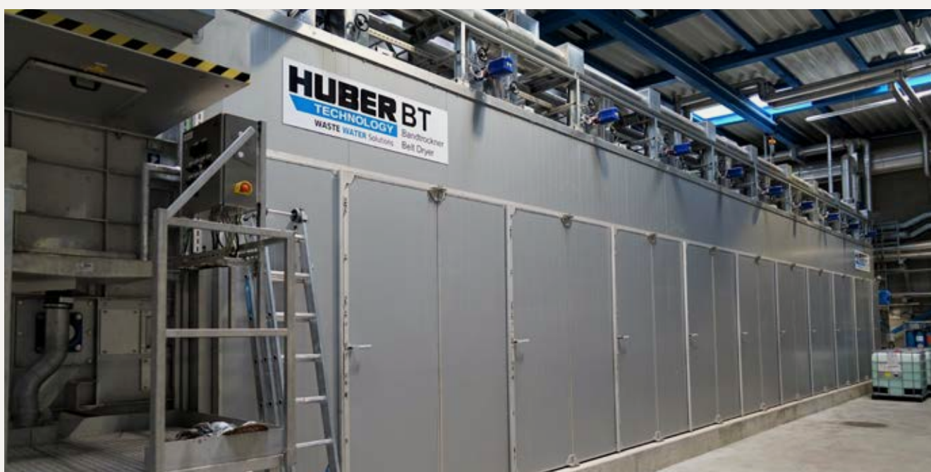
Innovative Klärschlamm-trocknung: Der HUBER Bandrockner BT ist eine der Hauptkomponenten der Anlage.
