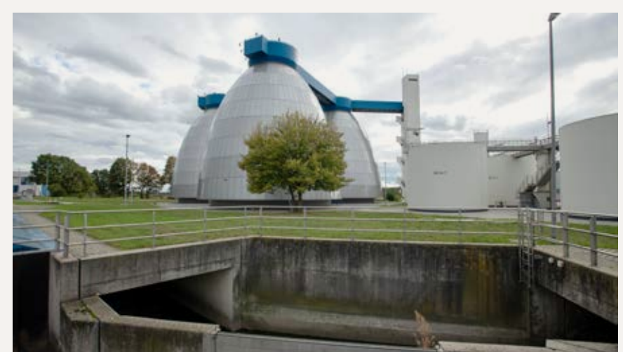
Das Klärwerk Mannheim: eines von 41 Großklärwerken in Baden-Württemberg (© Stadtentwässerung Mannheim – Fotostudio Werner Kissel).
