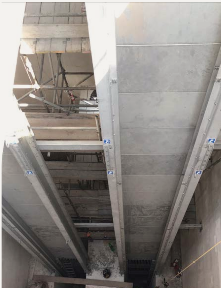
Blick in den Gerinneschacht während der Montage.
