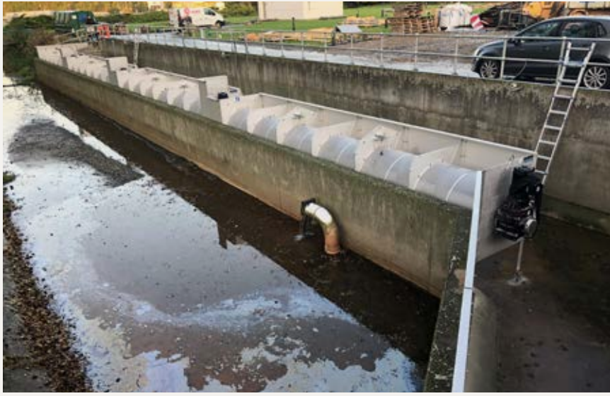
Die vier neuen HUBER Siebanlagen ROTAMAT® RoK2 zur Mischwassersiebung in Viby während der Montage: Die Siebung befindet sich vor der Entlastungsschwelle, sodass das Rechengut nicht über die Schwelle zurückgeführt werden muss.
