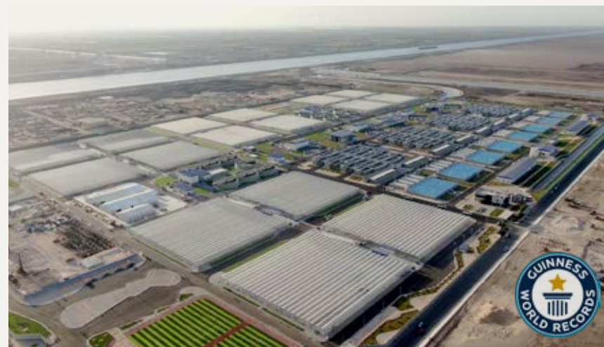
Anlage der Superlative: Die Wasseraufbereitungsanlage Bahr El-Baqar wurde unter anderem als größte Anlage zur Wasseraufbereitung und Schlammbehandlung der Welt ausgezeichnet.
