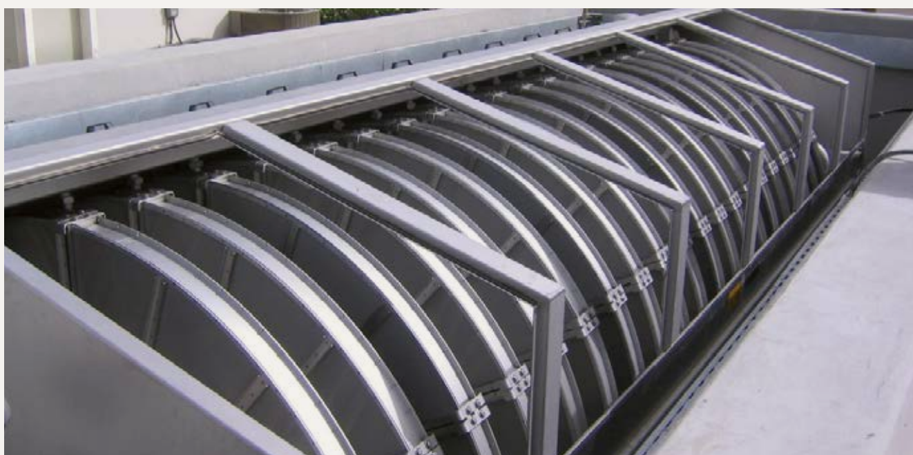
Der HUBER Scheibenfilter RoDisc® kommt vor allem dort zum Einsatz, wo eine sehr gute Filtratqualität und große Filterfläche erforderlich sind.
