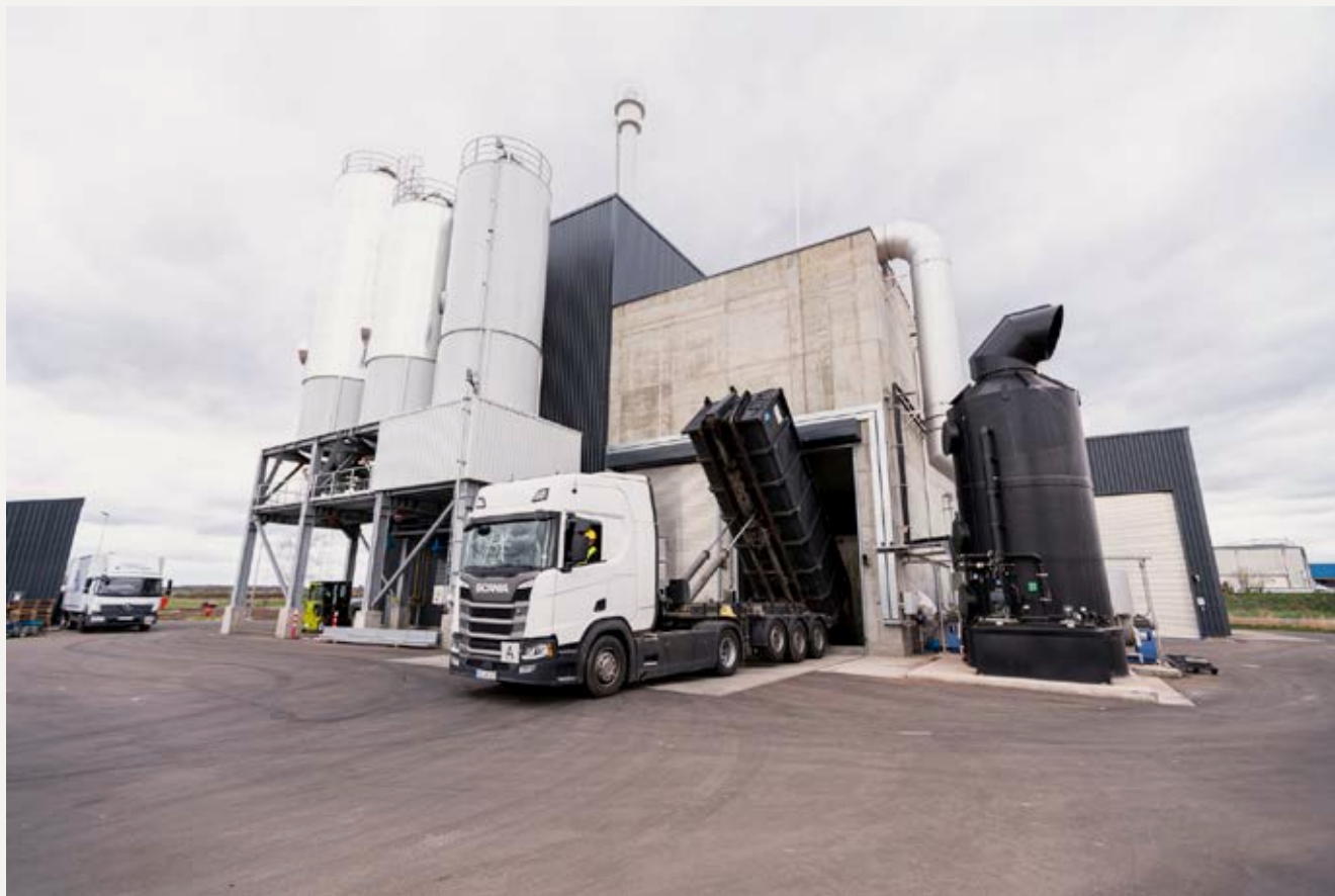
Bereit zur nachhaltigen thermischen Verwertung: Ein Lkw lädt Klärschlamm in den Klärschlamm-Bunker ab.
