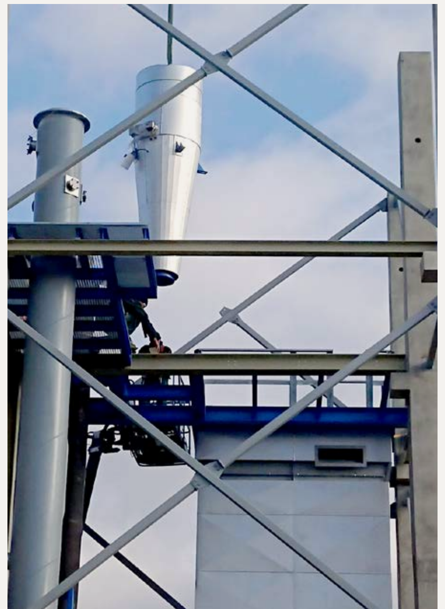
Einbau des Zyklons, der zukünftig unbehandelte Kesselasche abscheiden wird.
