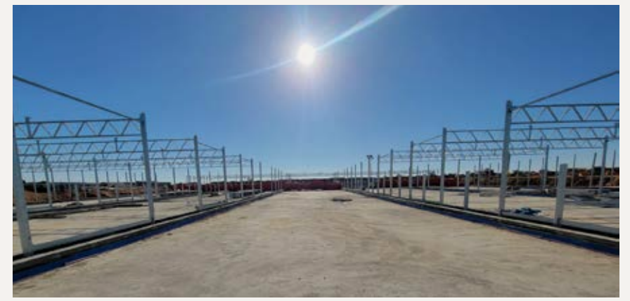
Baustelle Taif, Saudi Arabien: Installation der Unterkonstruktion des Gewächshauses.
