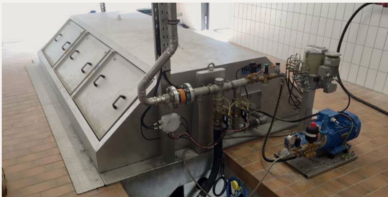
Vollautomatisiert: HUBER Trommelsieb LIQUID Masche als Feinstsiegung und wirtschaftliche Alternative für Vorklärbecken.
