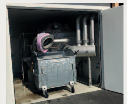
Abwurf des Siebguts in den Container
