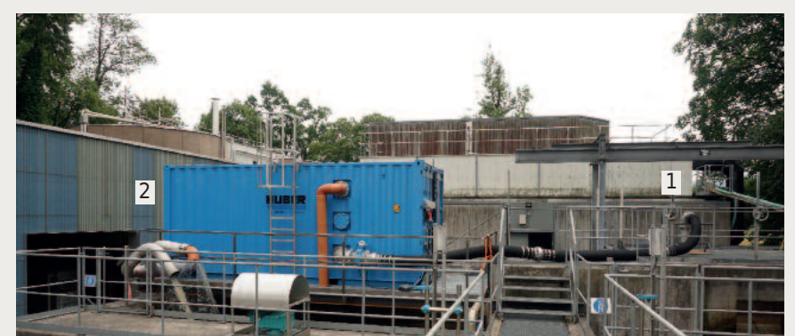
Abb. 2: Rückansicht der Versuchsanlage mit Beschickungspumpe [1] und Ablauf [2]
