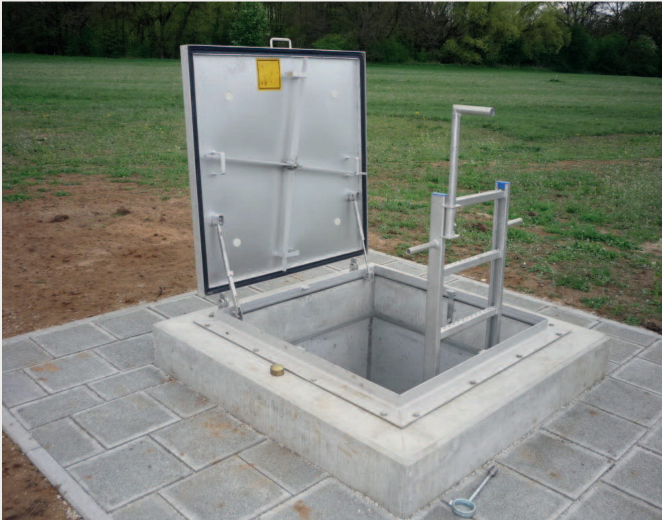
Bestehender Schachteinstieg neu saniert
