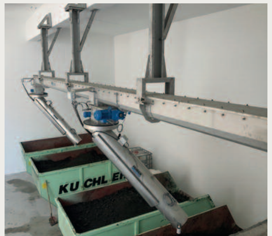
Abbildung 4: Lösung für Klärschlammtransport um 50.000 EW: Schlammverteilerschnecke mit voll automatisierter Schlammaufgabe für 4 Container durch Verteilerrutschen auf der KA Thyrnau.
