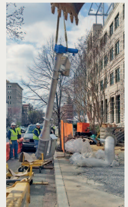
HUBER Schachtsiebanlage ROTAMAT® RoK4 während der Installation in einer unterirdischen Pumpstation im Zentrum von Washington D.C.
