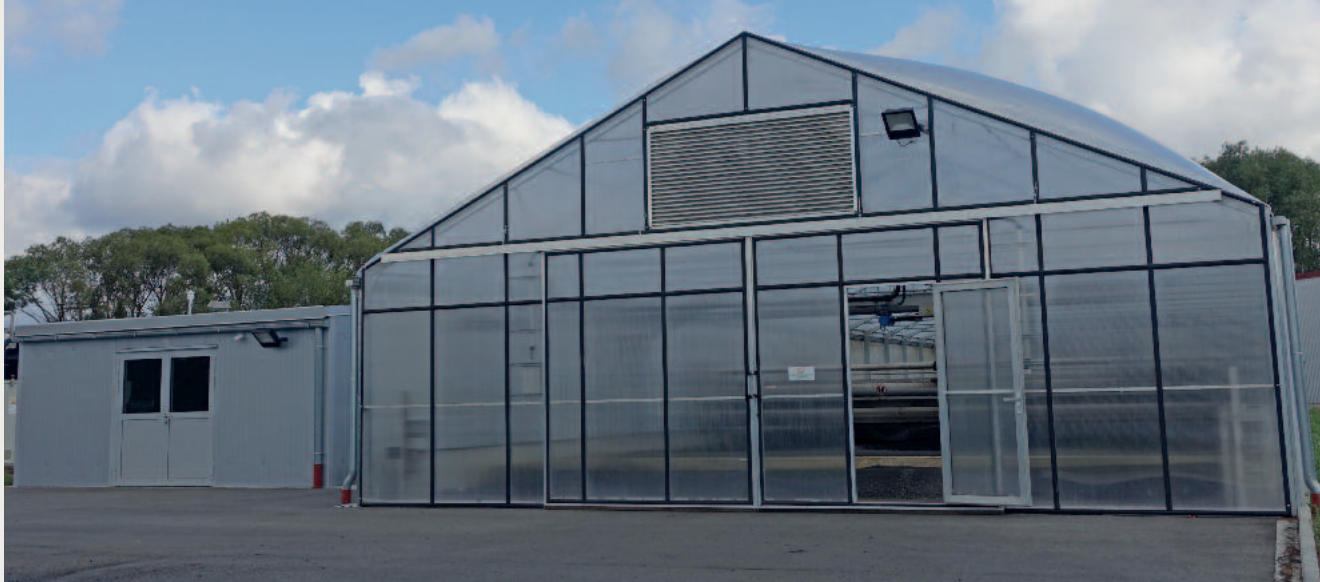
Die Schlammbehandlungsanlage ist vollständig automatisiert und wartungsarm
