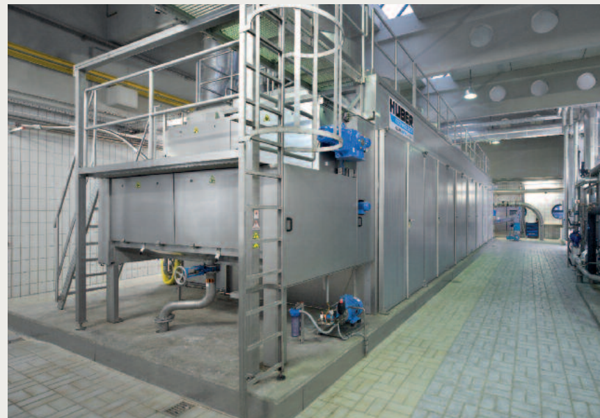
HUBER Bandrockner BT 16 mit Kondensationsstufe (rechts)
