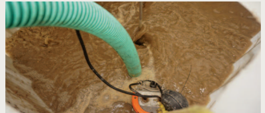
Abb. 6: Konzentriertes Siebgut aus der Versuchsanlage, aufgefangen im IBC-Container. Blick auf Rührwerk und Tauchmotorpumpe
