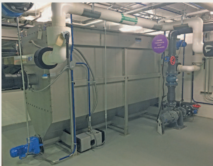
HUBER Abwasserwärmetauscher RoWin zur Extraktion von Energie aus Abwasser
