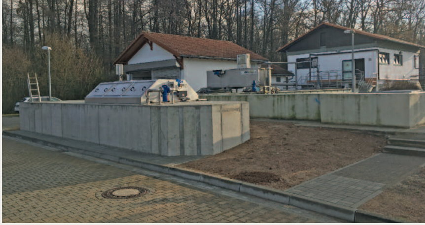
11 m x 3 m Platzbedarf für HUBER CarbonWin® - Prozess. Über 360 m 3 /h Durchsatzleistung inklusive statischen Schlammendicker als auch interne Brauchwasserrückführung (Ablauf Feinstsieb) zur Reinigung des Maschengewebes.
