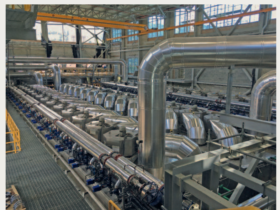
HUBER Bandrockner BT 30 (3 Linien) trocknen 400 t entwässerten Schlamm pro
