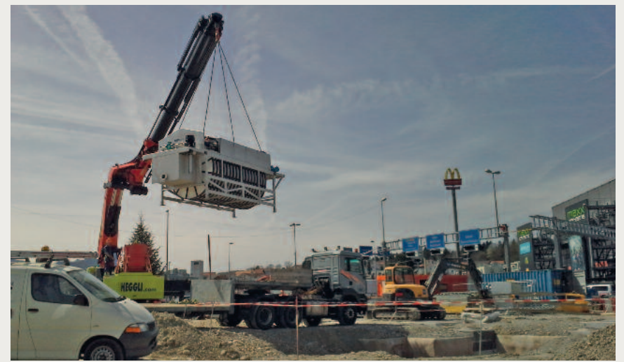
Montage der SABA Seetalplatz, unterirdisch in einem Kreisverkehr
