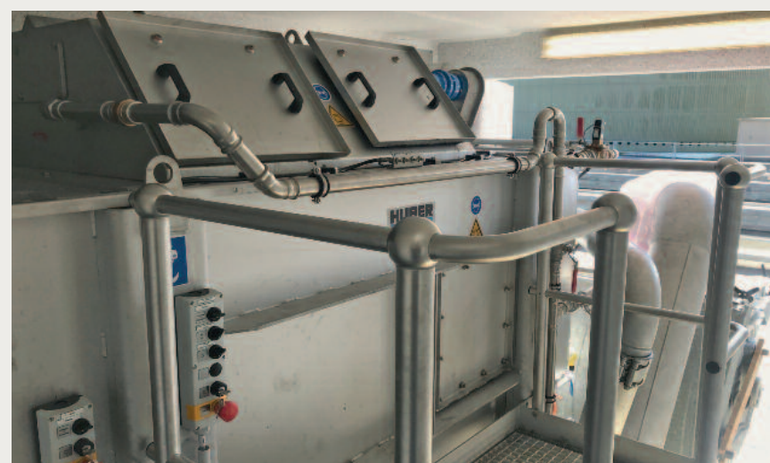
HUBER Trommelsieb LIQUID eingebaut in eine Fertigarage
