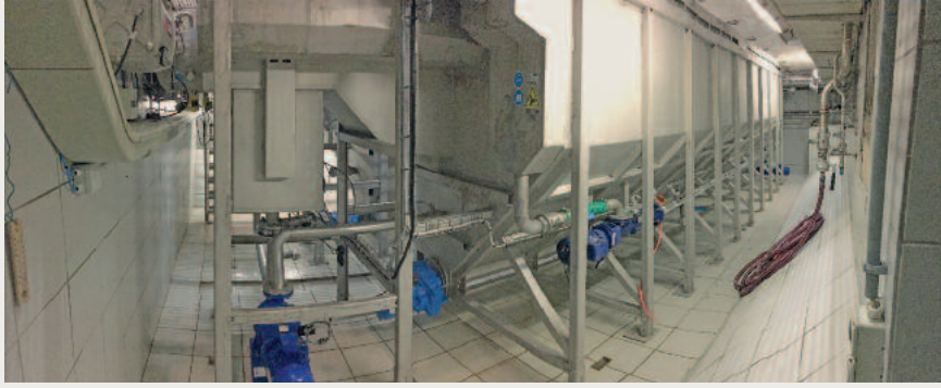
Abb.: 1: Gewohnte Schweizer Maßarbeit: Installation in Bestand
