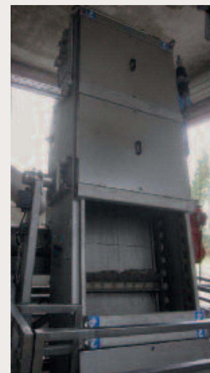
Der in das Gerinne fertig montierte Rechen
