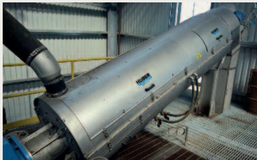
HUBER Schneckenpresse S-PRESS, zur Abwassersiebung und Vorentfrachtung des feststoffreichen Abwasser
