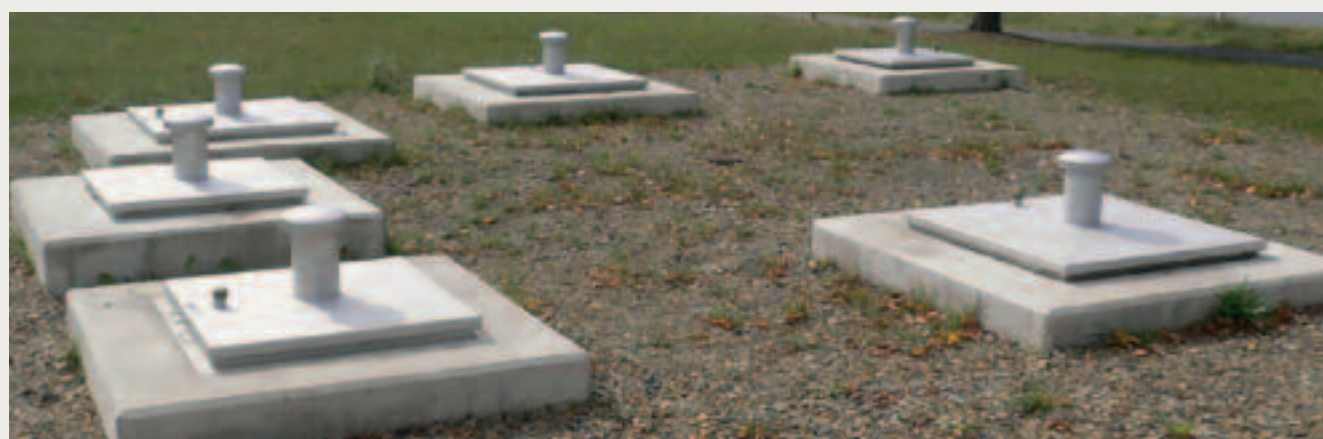
Einbruchhemmende Schachtabdeckungen gemäß DIN EN 1627
