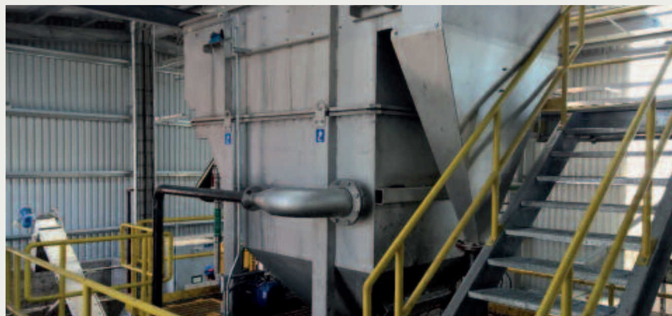
HUBER Druckentspannungsflotation HDF zur chemisch-physikalischen Vorbehandlung
