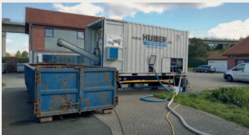
Im Vorfeld wurden Entwässerungsversuche mit der HUBER Schneckenpresse Q-PRESS® auf der Kläranlage Neustadt/Orla durchgeführt.
