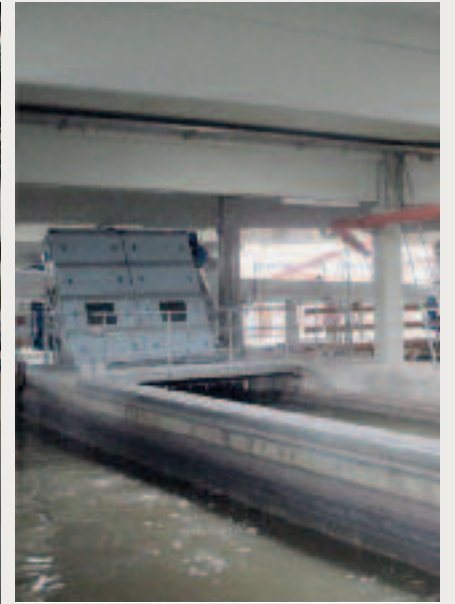
Einer der 3,2 m breiten HUBER Harken-Umlaufrechen RakeMax® Hybrid als Feinrechen mit Spaltweite 3 mm:
