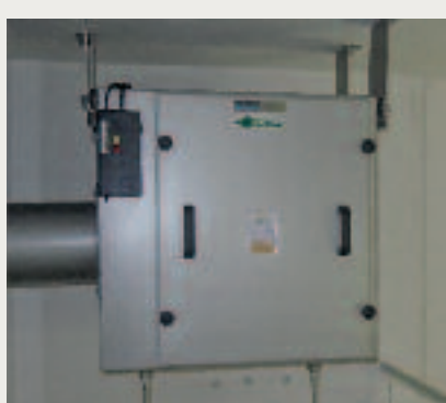
Individuelle auf den Kundenwunsch angepasste HUBER Luftfilteranlage L 361
