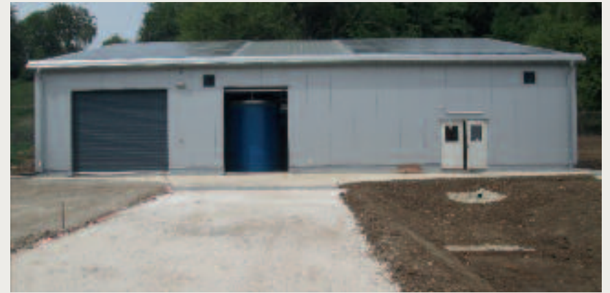
Neu entstandenes Maschinengebäude der Westerheimer Kläranlage mit zweistufiger Filtrationsanlage
