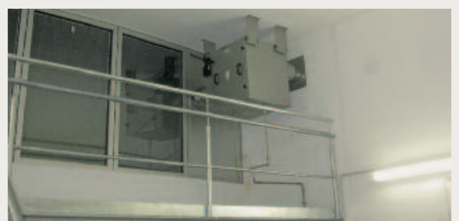
Die platzsparende, gut zugängliche HUBER Luftfilteranlage
