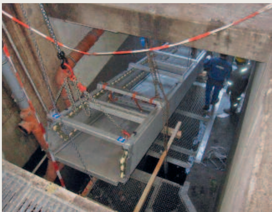
Auch diese beengte Situation war für das Montageteam kein Problem.
