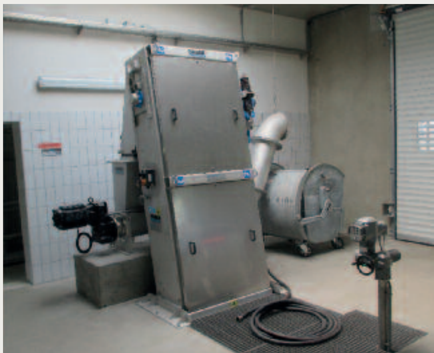
HUBER Harken-Umlaufrechen RakeMax® mit der dazugehörigen HUBER Waschpresse WAP®.
