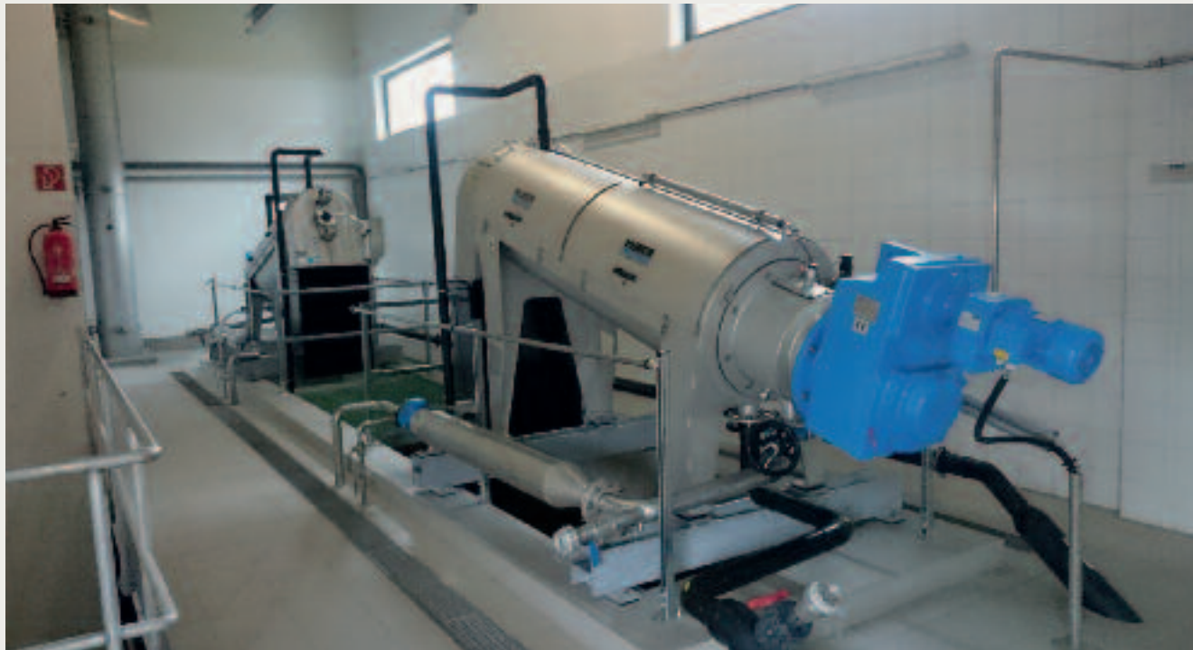
Zwei HUBER Schneckenpressen Q-PRESS® 440 nach der beendeten Montage
