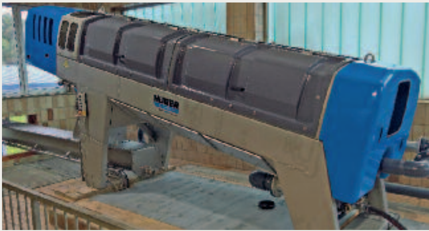
Festinstallation HUBER Schneckenpresse Q-PRESS® 620.2
