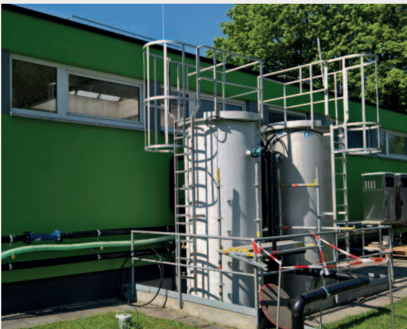
Abbildung 1: Aktivkohlefiltration auf der ZABA bei Boehringer Ingelheim
