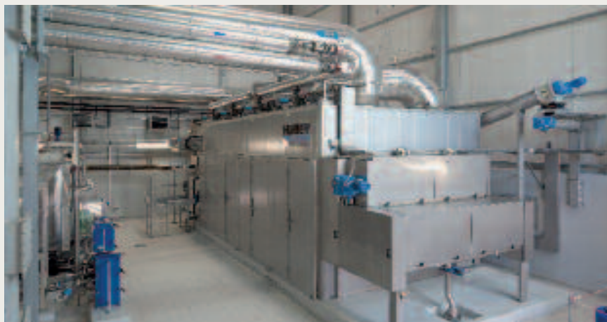
HUBER Bandtrockner BT trocknet Klärschlamm auf 92 % TR
