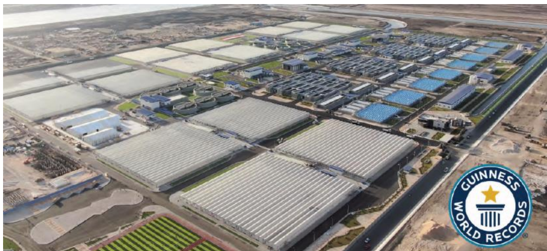
Abbildung 45: Sauberes Wasser für die Sinai-Halbinsel: Die Wasseraufbereitungsanlage Bahr El-Baqar (Ägypten) ist 2021 von Guinness World Records als weltweit größte Anlage dieser Art ausgezeichnet worden. Jährlich sollen hier auf einer Fläche von etwa 650.000 Quadratmetern über zwei Milliarden Kubikmeter Wasser aufbereitet werden. HUBER lieferte hier unter anderem 128 Schlammwender SOSLTICE® um jährlich 490.000 Tonnen entwässerten Schlamm mit Hilfe der Sonne zu trocknen.
